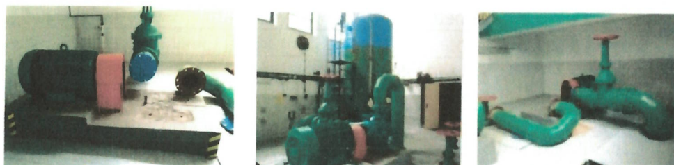
Obr. č.1 Interiér čerpacej stanice
