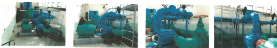
Obr. č.1 Interiér čerpacej stanice
