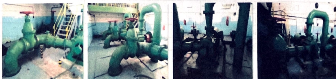
Obr. č.1 Interiér čerpacej stanice
