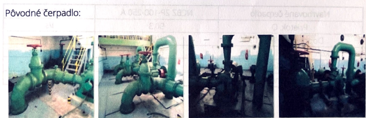
Obr. č.1 Interiér čerpacej stanice
